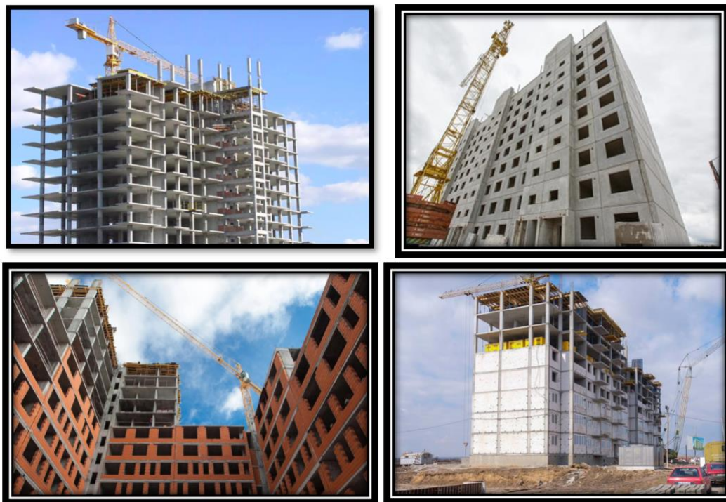
Рис. 1. Типы конструктивных систем при строительстве жилых домов в Санкт-Петербурге. 1 - Монолитное строительство; 2 – Панельное строительство; 3 – Кирпичная кладка; 4 – Сборно-монолитные технологии
