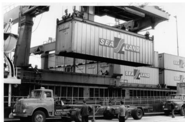
Рисунок 7. Перевалка контейнера, разработанного М. Маклином (примечательна надпись «SeaLand» – с торца контейнера), с автомобильной платформы на борт судна, Германия, 1966
