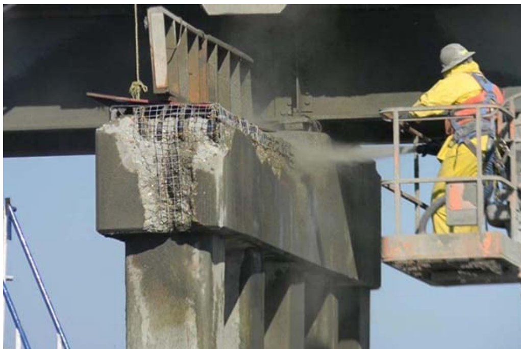
Рис. 2 Торкретирование опорных частей
