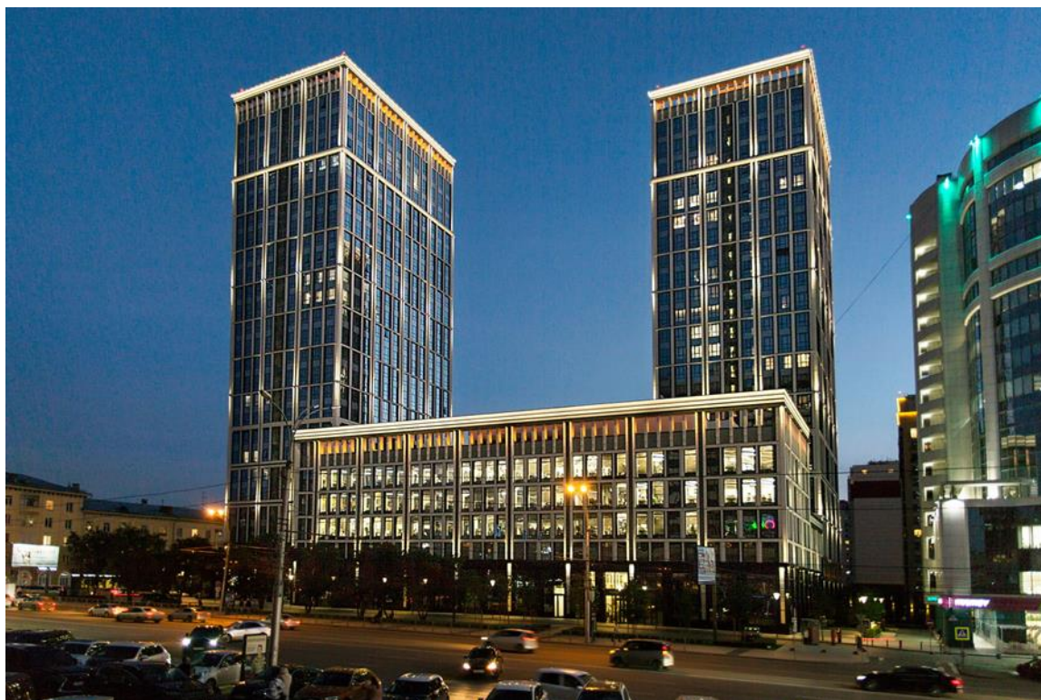
Рисунок 1. МФК «Ричмонд» (2019-2022 гг.). Фотография реализованного объекта. Автор фото: Петропавловская Ю. [5].
