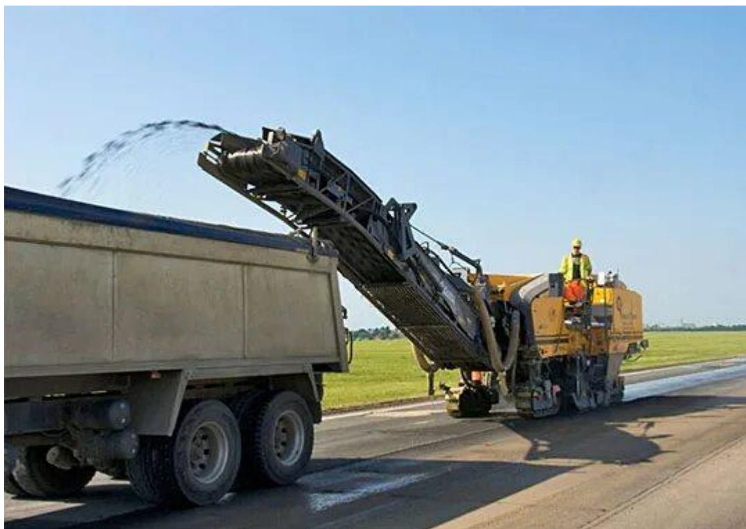
Рисунок 1 – Процесс демонтажа старого покрытия
