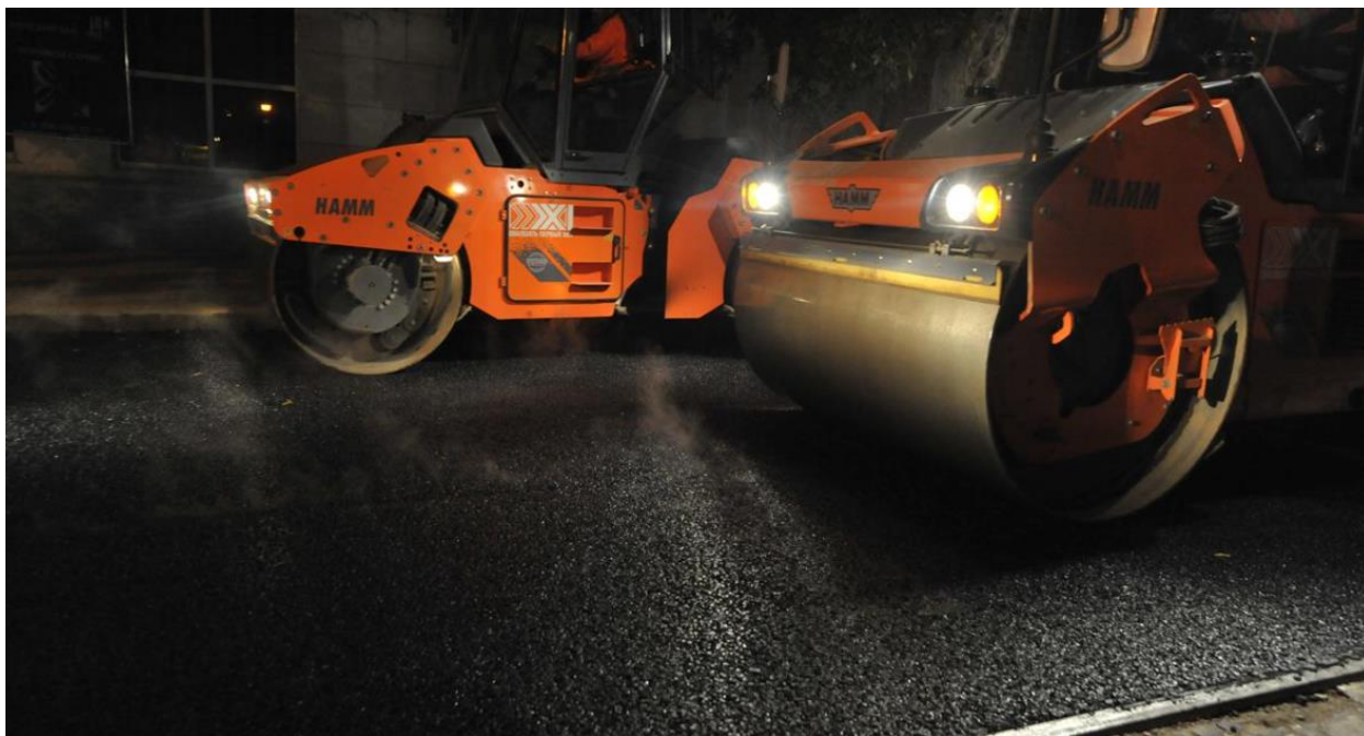
Рисунок 1 – Ремонт дорожного покрытия по улице Красноармейской в 2017 году
