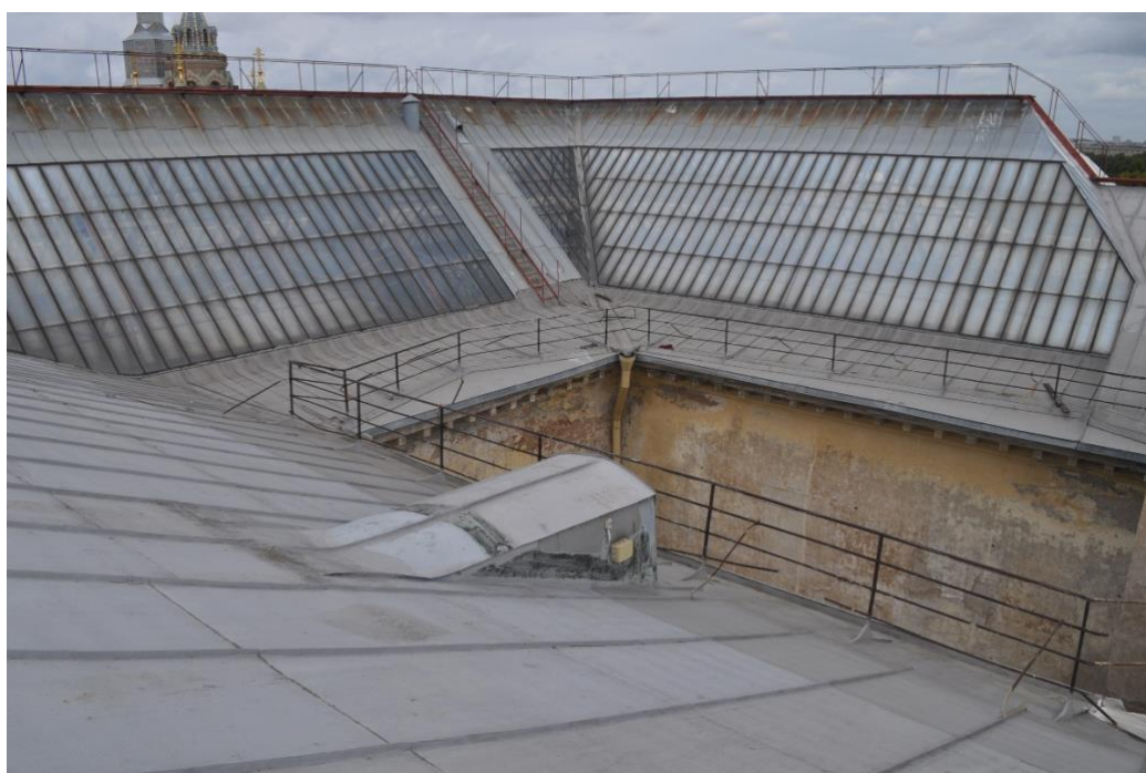
Рис.2 Вид светового фонаря с кровли здания
