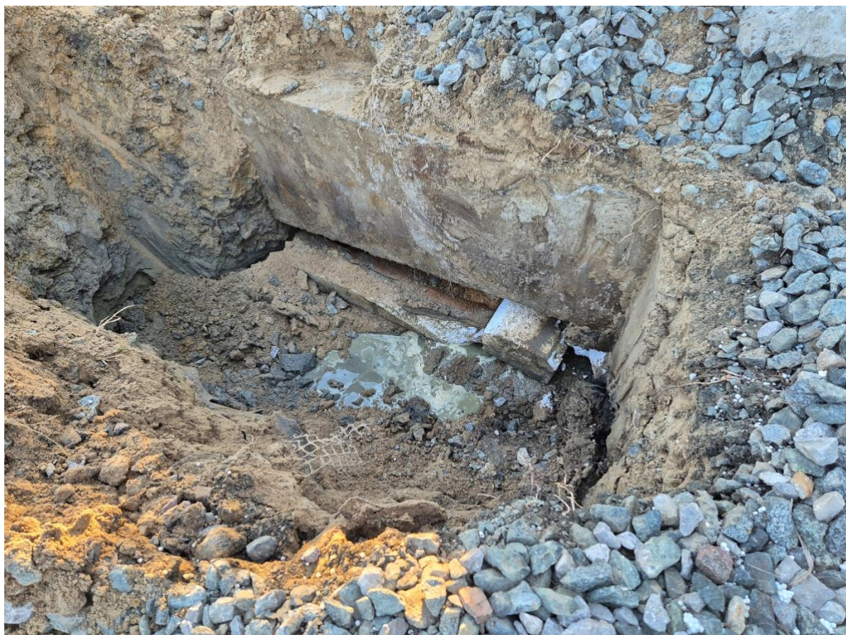
Рис. 1. Откопанный шурф под объектом обследования (иллюстрация авторов)
