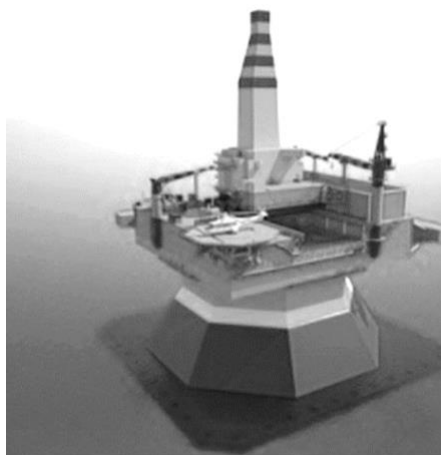
Рисунок 5. Морская ледостойкая буровая установка ЦКБ МТ «Рубин» [8]
